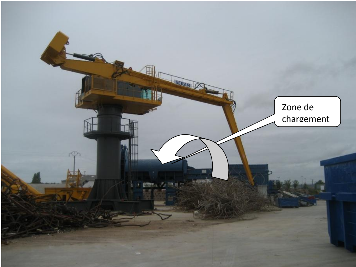
Photo de l'installation du site de Migné-Auxances (86440)
