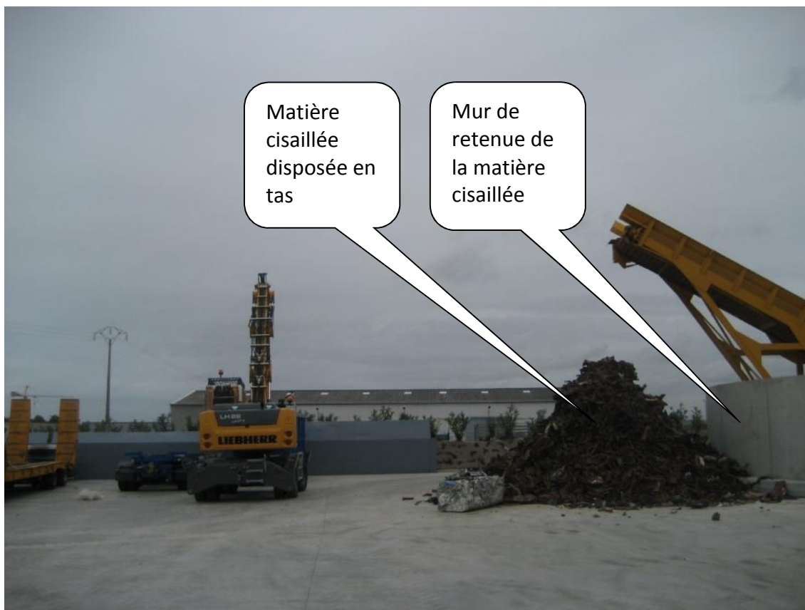
Photo de l'installation du site de Migné-Auxances (86440)
